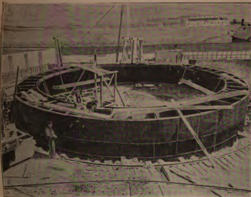
Fig. 219. — Montage du caisson du puits n° 4. — Première phase.
